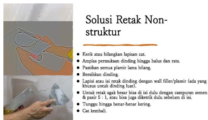
Gambar 6 Solusi retak non-struktur
