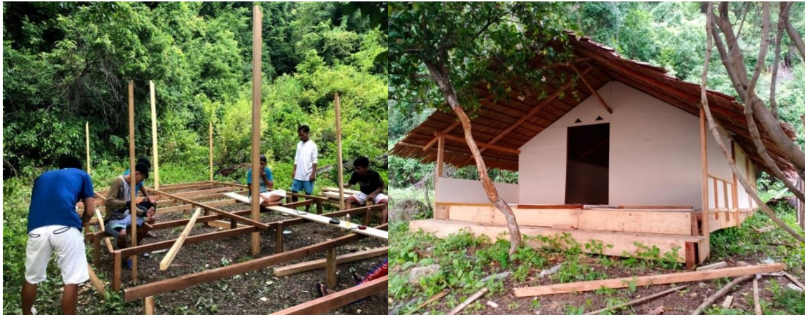
Gambar 8. Proses pembangunan ruang informasi.
