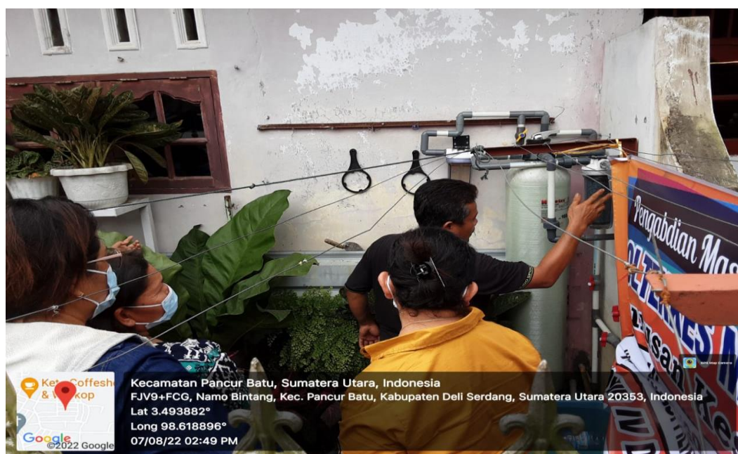
Gambar 5: Pemasangan Unit Pengolah Air
