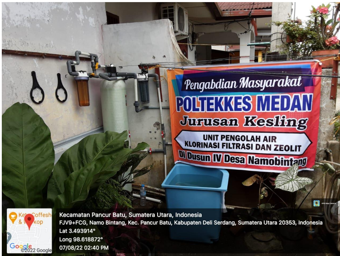
Gambar 6 : Unit Pengolah Air Yang Sudah Selesai di Pasang
