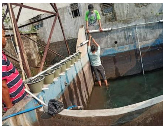
Gambar 2 Pemasangan Instalasi Akuaponik
